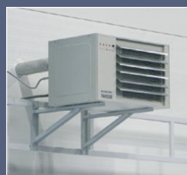
монтаж агрегата на стену
