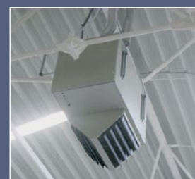
монтаж агрегата под потолок
