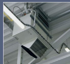
монтаж агрегата под потолок
